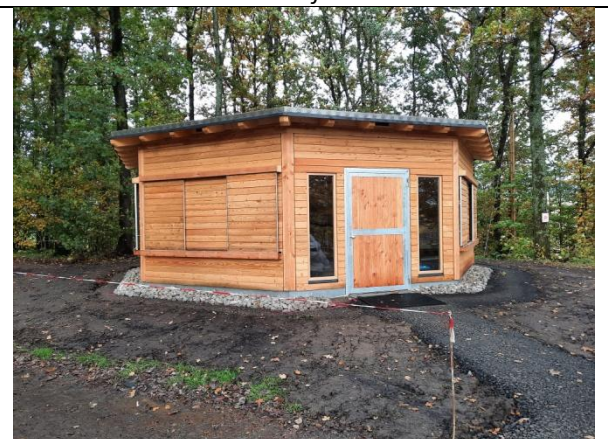
Pavillon nach Fertigstellung der Außenflächen
