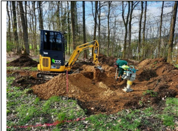
Bodenauskoffung im Baufeld
