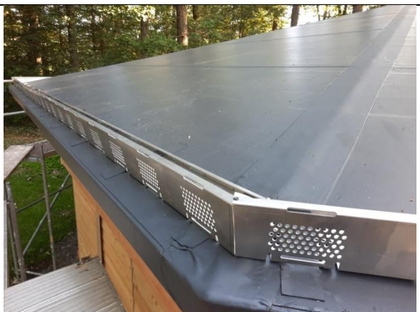
Dachabdichtung für die Dachbegrünung
