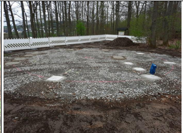
Schotterschicht und Einzelfundamente
