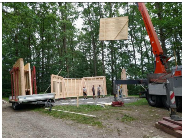
Aufstellen der vorgefertigten Wandelemente
